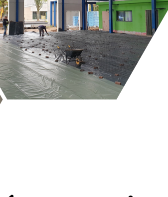
05/11 Plaatsen isolatie en betonroosters
